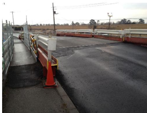
図7 覆工板仮橋の状況
